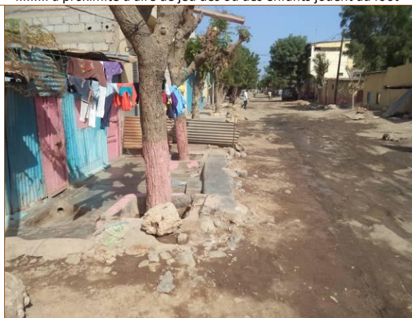
voirie urbaine défectueuse
