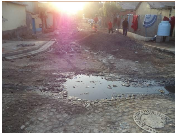
Problème d'assainissement dans le quartier
