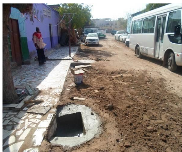
Ouvrage pour eaux grises évités (rue 36)
