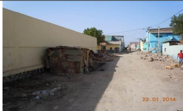
Abris en tôles sur l'axe 53
