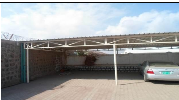
Parking métallique sur le site (à démonter)
