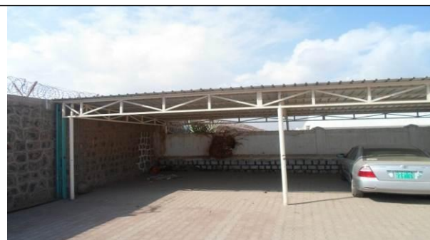
Parking métallique sur le site (à démonter)
