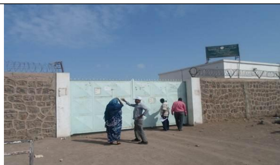
Façade extérieure du site (mur à casser)
