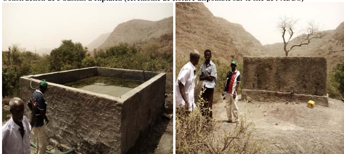
Construction de 5 bassins à Riptaleh (cérémonie de clôture disponible sur le site de l'ADDS)
