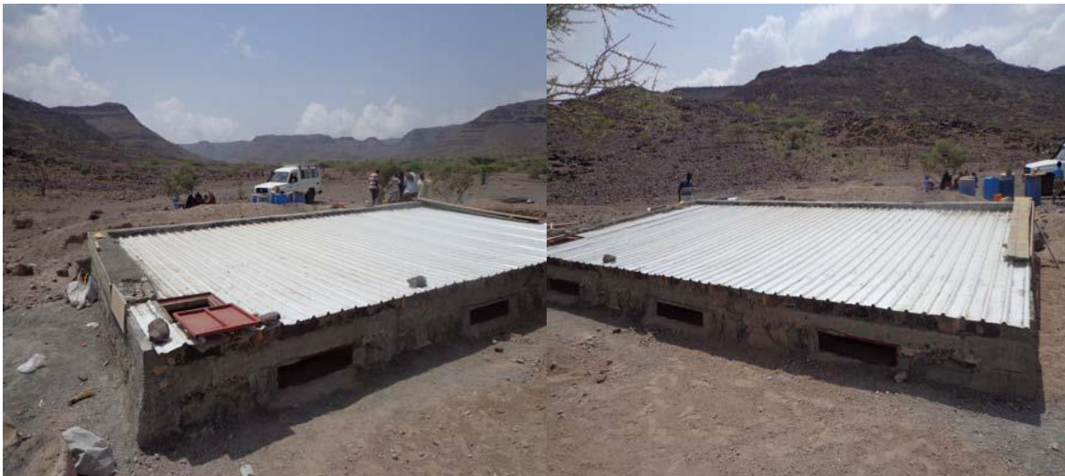
Construction d'une citerne enterrée à Taarori
