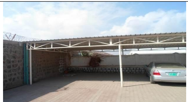
Parking métallique sur le site (à démonter)
