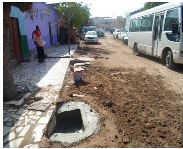
Ouvrage pour eaux grises évités (rue 36)
