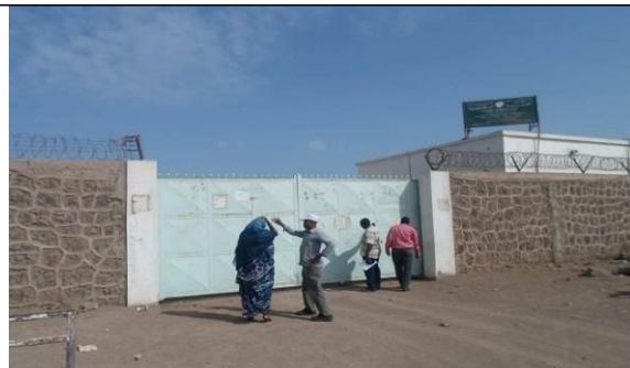
Façade extérieure du site (mur à casser)
