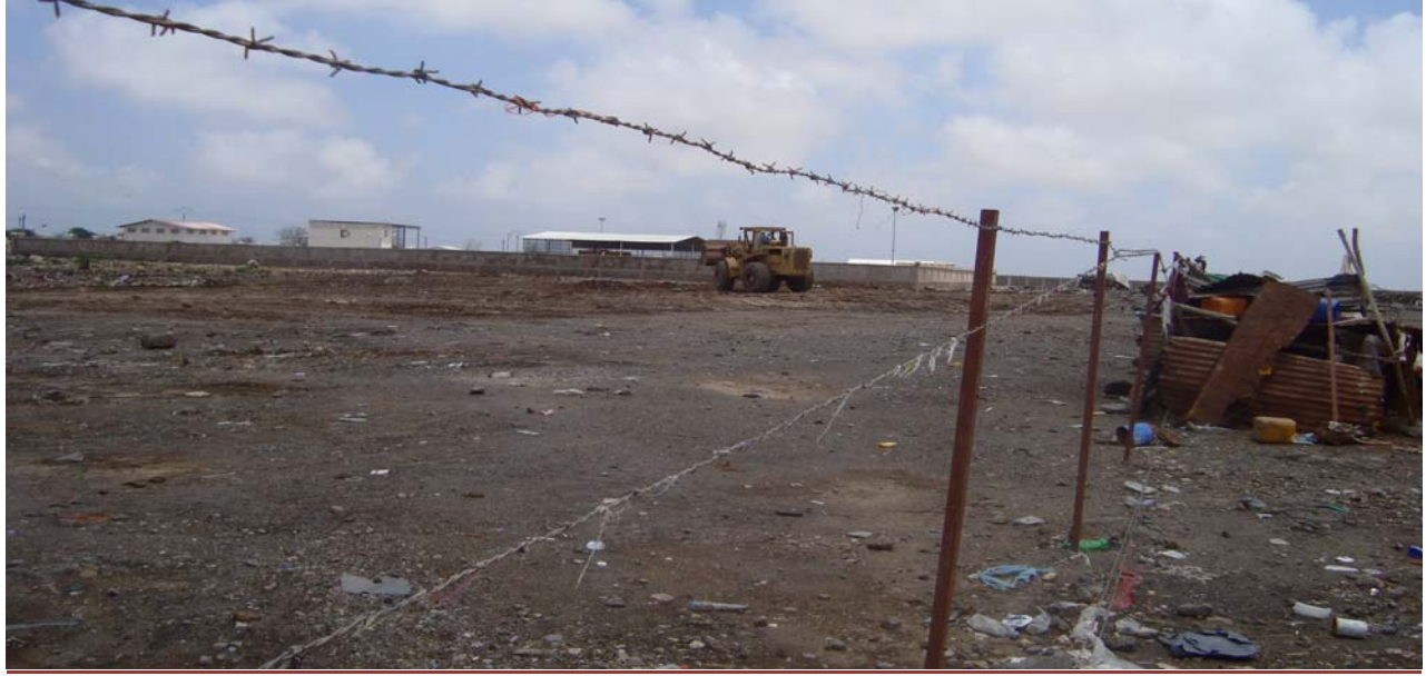
NETTOYAGE DU TERRAIN DU CENTRE DE FORMATION
