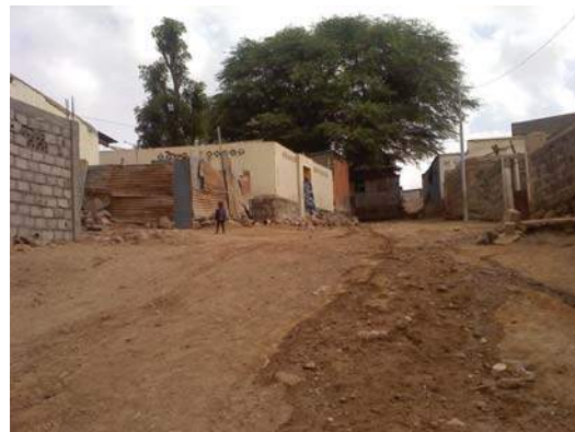
Arta - Habitat consolidé - Photos du consultant
