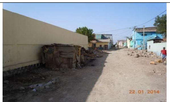
Abris en tôles sur l'axe 53
