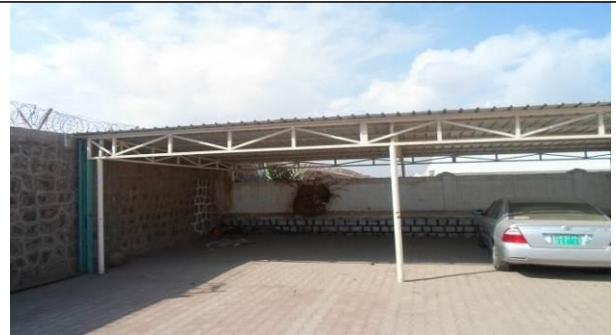
Parking métallique sur le site (à démonter)
