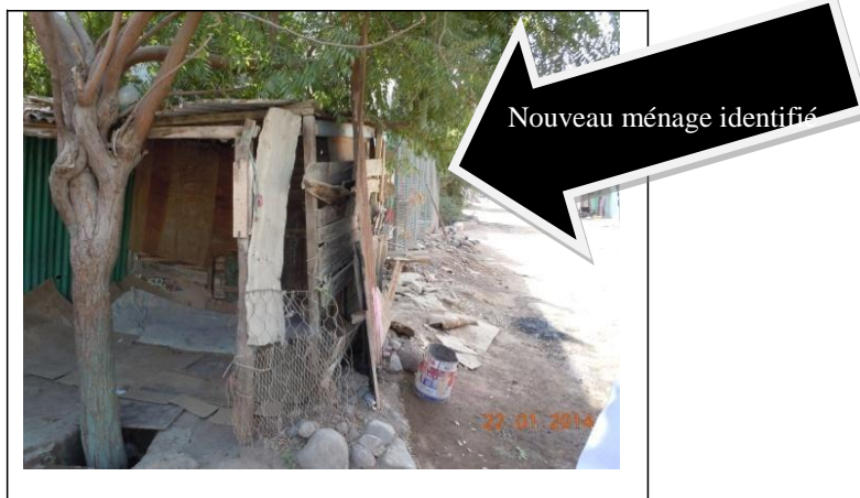
Piquet en bois et toitures en tôles (axe 39)
