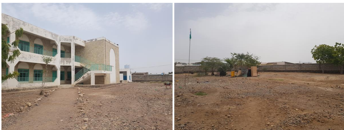
Figure 3 : (à gauche) Lycée d'Obock ; (à droite) terrain du lycée où est prévue la construction des salles scientifiques
