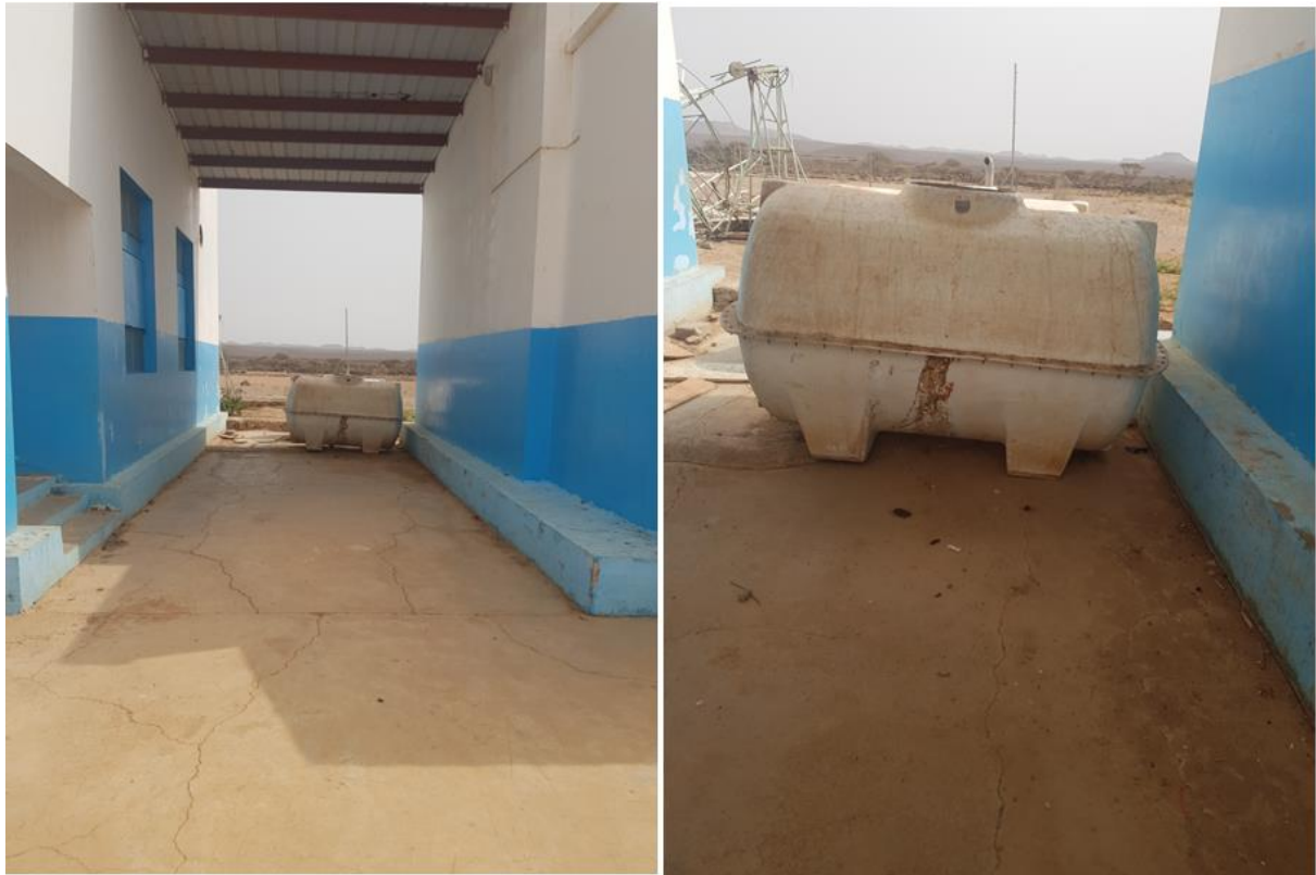
Figure 7 : Réservoir d'eau potable pour les élèves du collège (réservoir non sécurisé contre les singes ; risques sanitaires)
